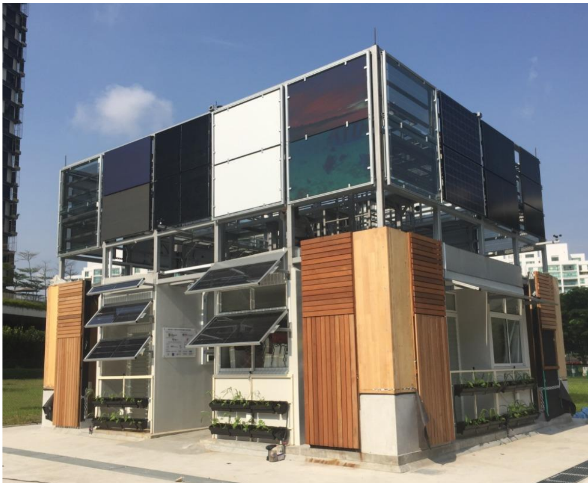
Рис. 1. – Пример использования системы производительного фасада в конструкции здания Лаборатории тропических технологий Национального университета Сингапура
