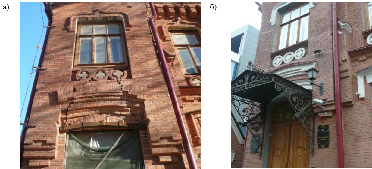
Рис. 1 – Фрагмент стены архитектурного памятника XIX века (а – до реконструкции; б – после реконструкции)
