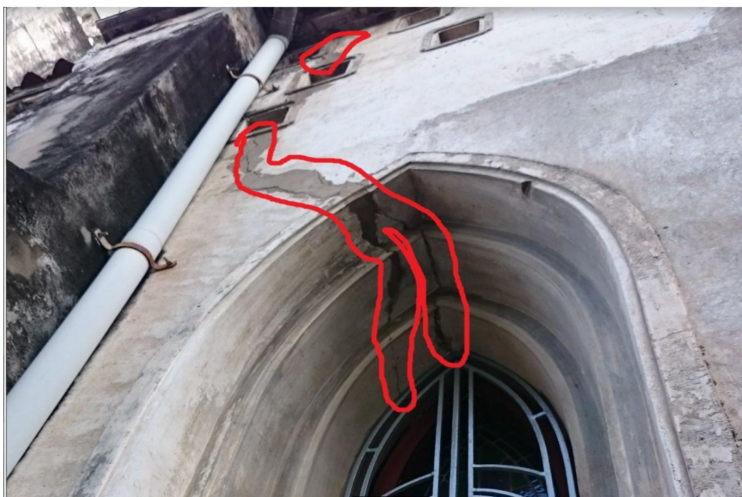
Рис. 10 – Образование трещин в стенах, на купольном окне и биофленок различной плотности серо-черного цвета - фрагмент северо-западного фасада Ханойского Кафедрального собора (Ханой-2016)
