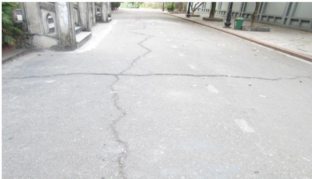
Рис. 11 – Формирование трещин в дорожном покрытии вблизи Ханойского Кафедрального собора (Ханой-2016)
