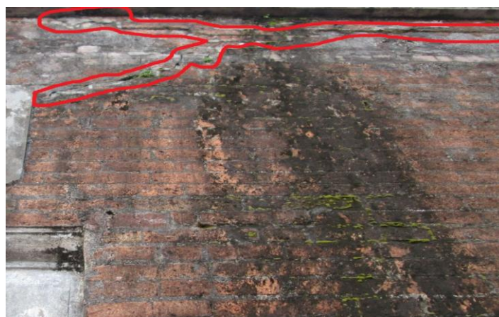
Рис. 6 – Образование трещин и биообрастаний на северном фасаде второго этажа Ханойской Флаговой башни (Ханой-2016)
