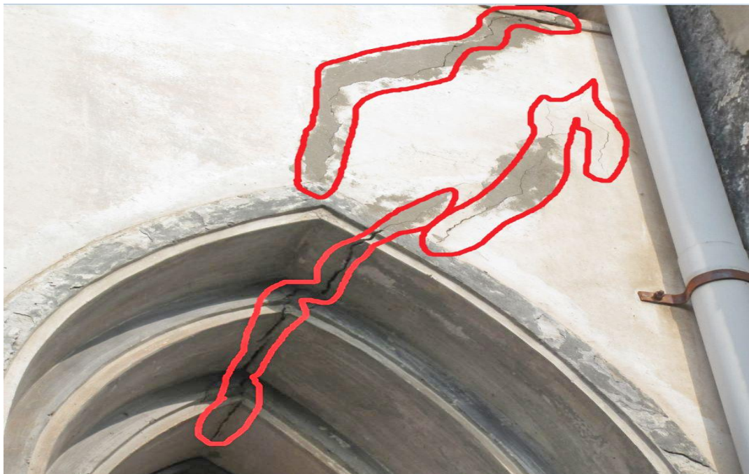
Рис. 9 – Образование трещин в стенах и на купольном окне на южно-восточном фасаде Ханойского Кафедрального собора (Ханой-2016)
