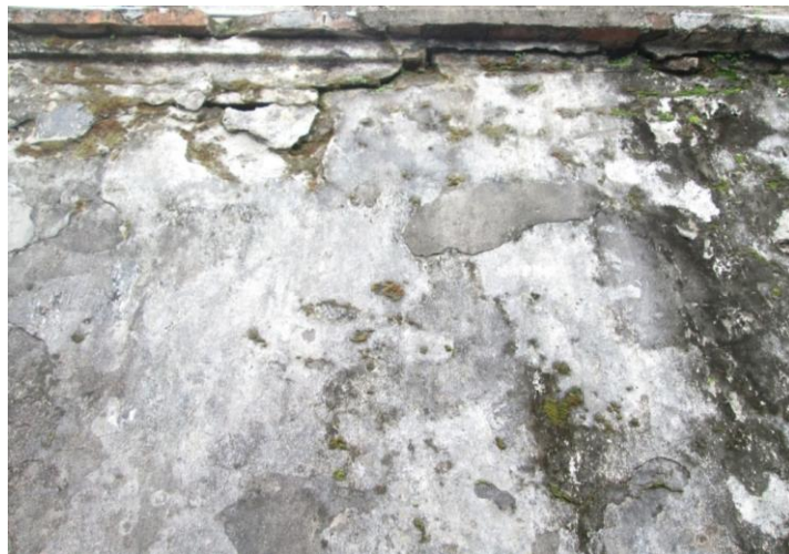
Рис. 5 – Образование трещин и биообрастаний биопленок различного состава на восточном фасаде первого этажа Ханойской Флаговой башни (Ханой-2016)
