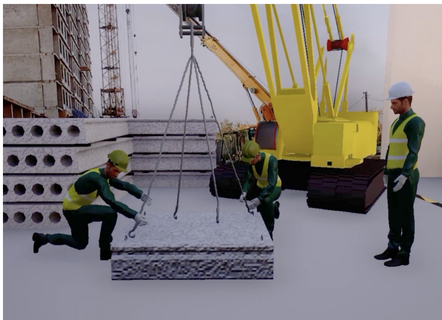
Рисунок 2 - Строповка железобетонной конструкции четырехветвевым стропом для ее подъема на монтажную отметку DOI: https://doi.org/10.23670/IRJ.2023.138.51.2
