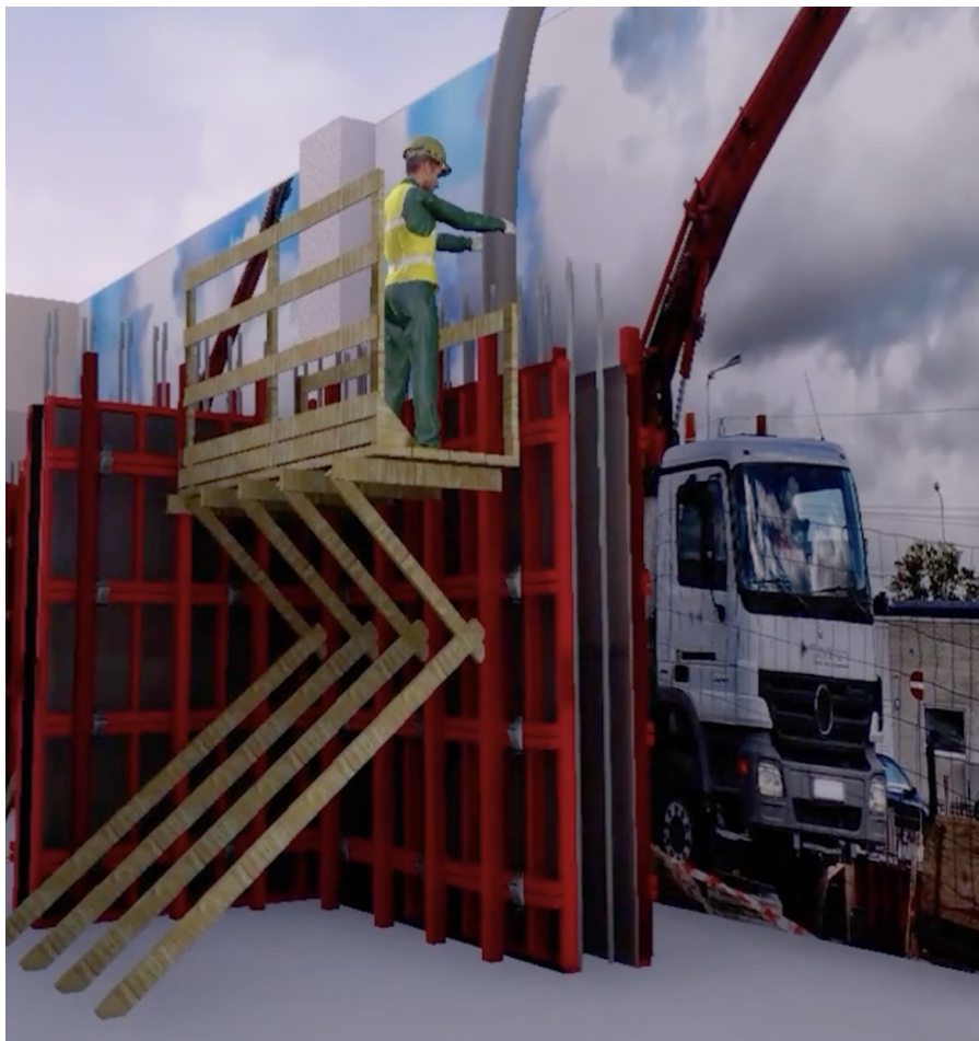
Рисунок 4 - Бетонирование стен в щитовой опалубке DOI: https://doi.org/10.23670/IRJ.2023.138.51.4
