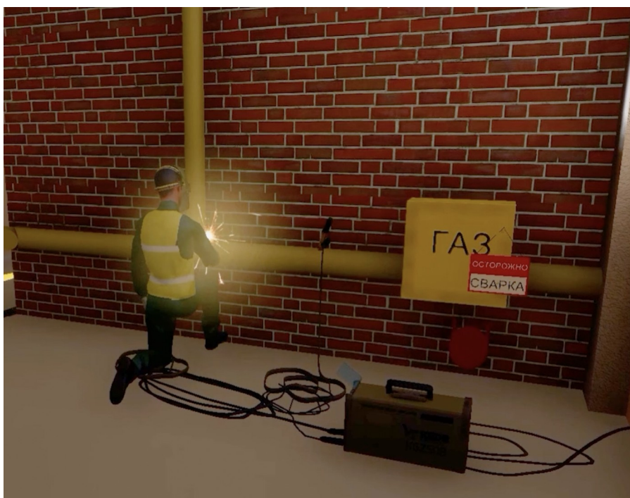
Рисунок 5 - Вваривание новой трубы на участке действующего газопровода DOI: https://doi.org/10.23670/IRJ.2023.138.51.5
