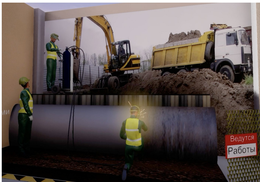
Рисунок 3 - Газовая резка труб на дне выемки DOI: https://doi.org/10.23670/IRJ.2023.138.51.3
