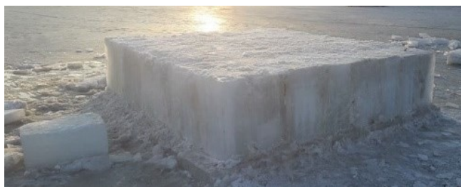
Рисунок 2 - Кладка из ледовых блоков DOI: https://doi.org/10.23670/IRJ.2023.138.196.2
