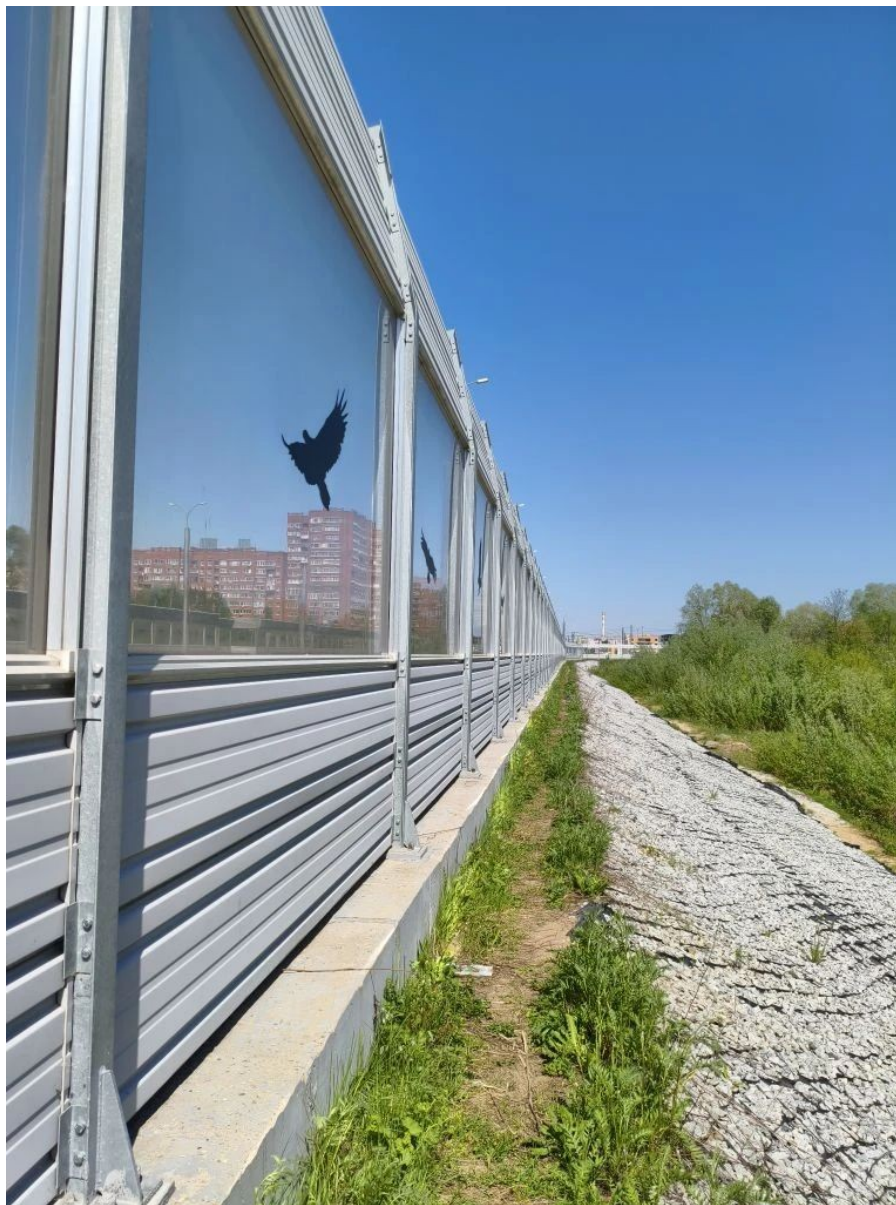
Рисунок 2 - Шумозащитные экраны вдоль автодороги на территории «Сосновой рощи»
