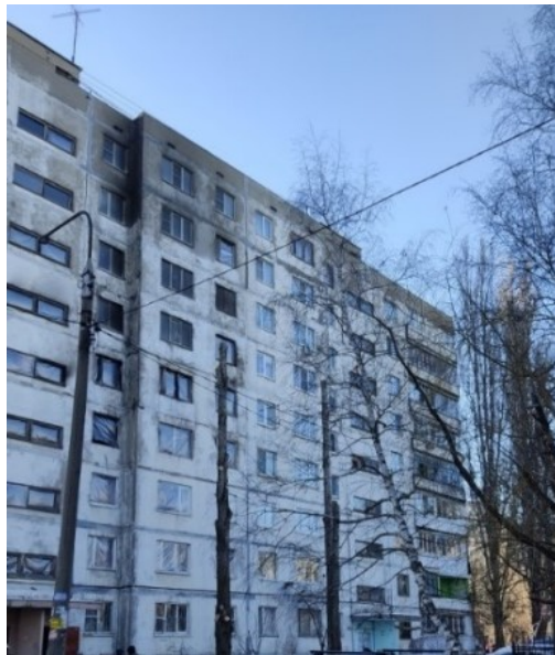
Рисунок 13 - Фасад здания после взрыва DOI: https://doi.org/10.60797/IRJ.2026.167.82.20
