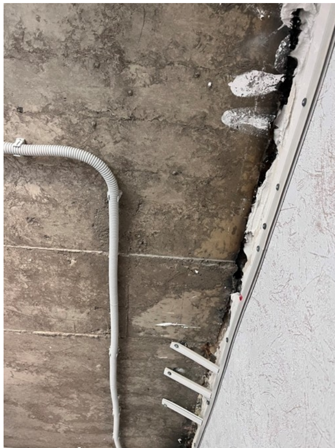
Рисунок 16 - Плита перекрытия, восстановленная после аварии DOI: https://doi.org/10.60797/IRJ.2026.167.82.26
