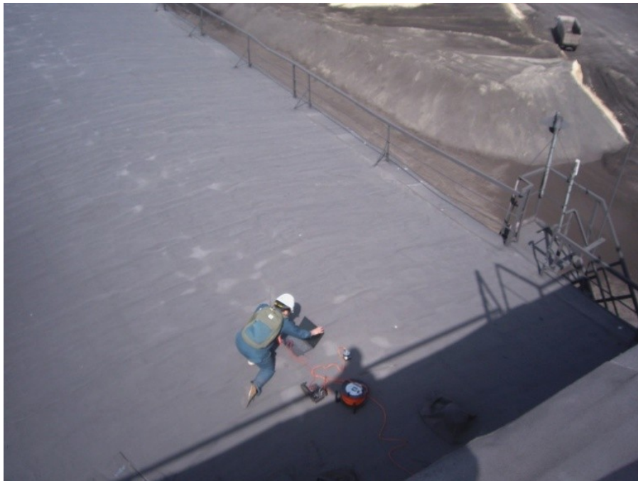
Рисунок 6 - Установка датчиков в осях 1-2-3-4-5-7 галереи и приводной станции DOI: https://doi.org/10.60797/IRJ.2026.167.82.9
