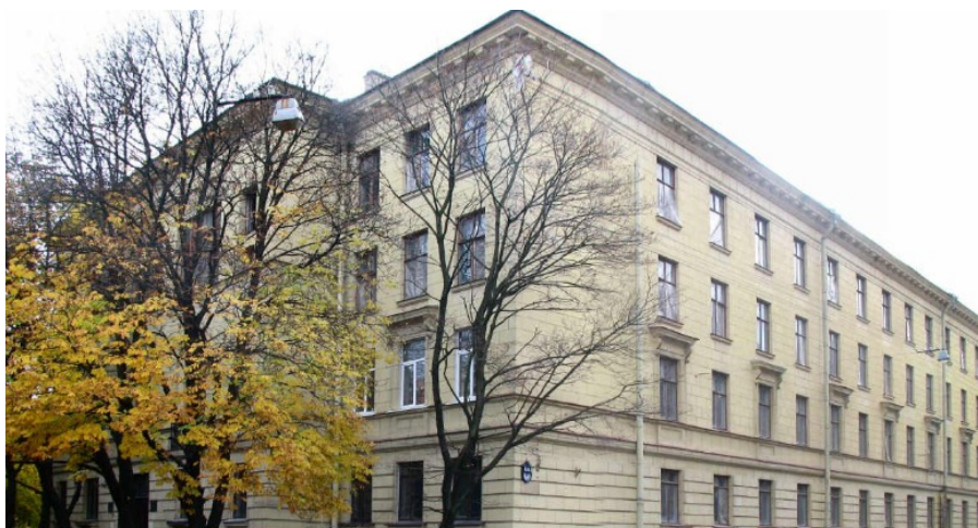
Рисунок 4 - Дом №5 ул. Большая Посадская, г. Санкт-Петербург DOI: https://doi.org/10.60797/IRJ.2026.169.4.4
