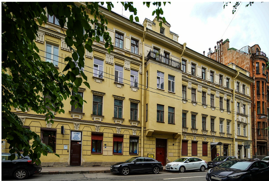
Рисунок 2 - Дом №3 ул. Большая Посадская, г. Санкт-Петербург DOI: https://doi.org/10.60797/IRJ.2026.169.4.2
