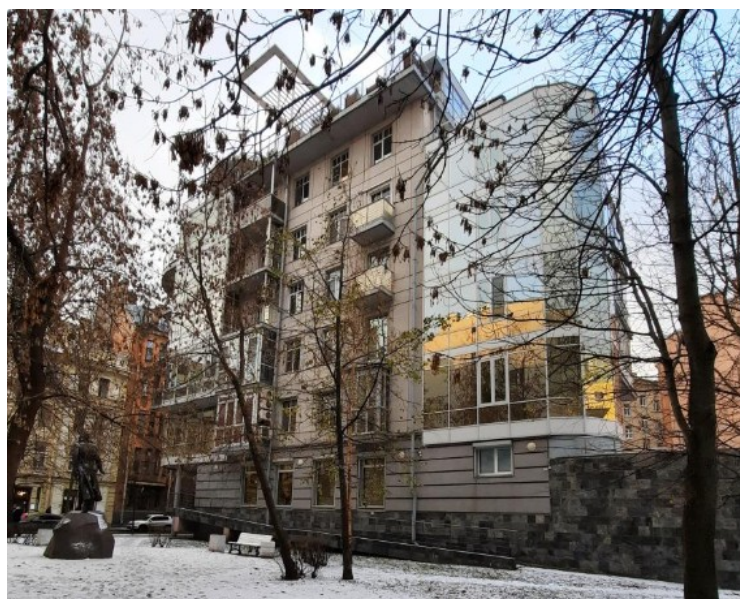
Рисунок 5 - Дом № 6 ул. Большая Посадская, г. Санкт-Петербург DOI: https://doi.org/10.60797/IRJ.2026.169.4.5
