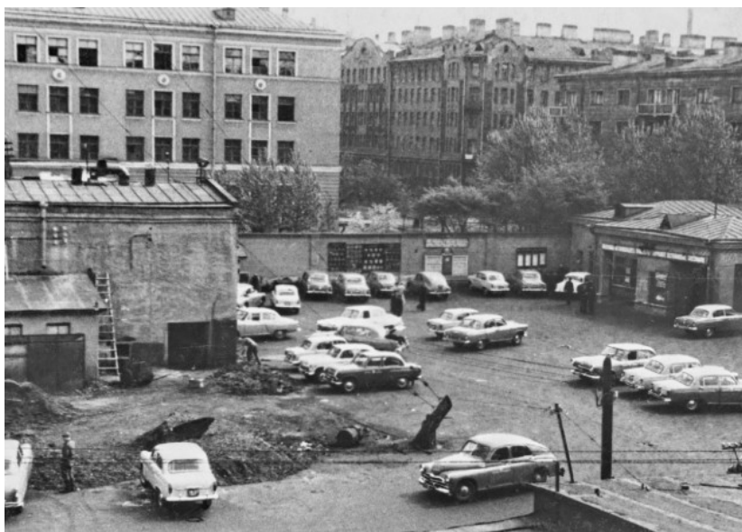
Рисунок 7 - Дом № 14 ул. Большая Посадская, г. Санкт-Петербург DOI: https://doi.org/10.60797/IRJ.2026.169.4.7
