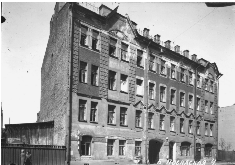
Рисунок 3 - Дом № 4 ул. Большая Посадская, г. Санкт-Петербург DOI: https://doi.org/10.60797/IRJ.2026.169.4.3
