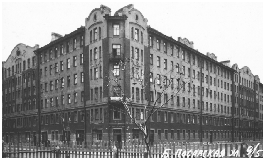
Рисунок 6 - Дом № 9/5 ул. Большая Посадская, г. Санкт-Петербург DOI: https://doi.org/10.60797/IRJ.2026.169.4.6
