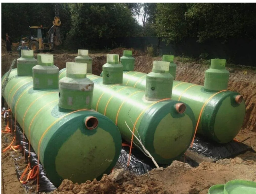
Рисунок 2 - Локальные очистные сооружения DOI: https://doi.org/10.60797/IRJ.2025.158.105.2
