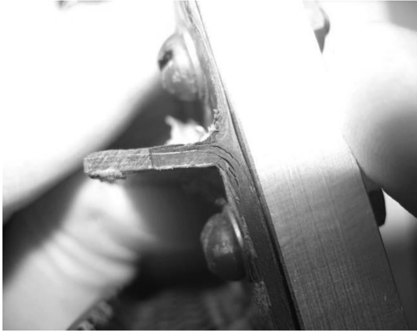
Рисунок 8 - Фотография разрушения нижнего рельса, расслоение слоев углепластика DOI: https://doi.org/10.60797/IRJ.2025.153.97.8
