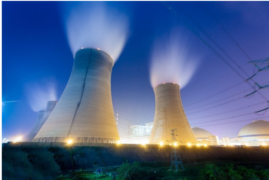
Рисунок 3 - Современная конденсационная электростанция DOI: https://doi.org/10.60797/IRJ.2024.149.104.4
