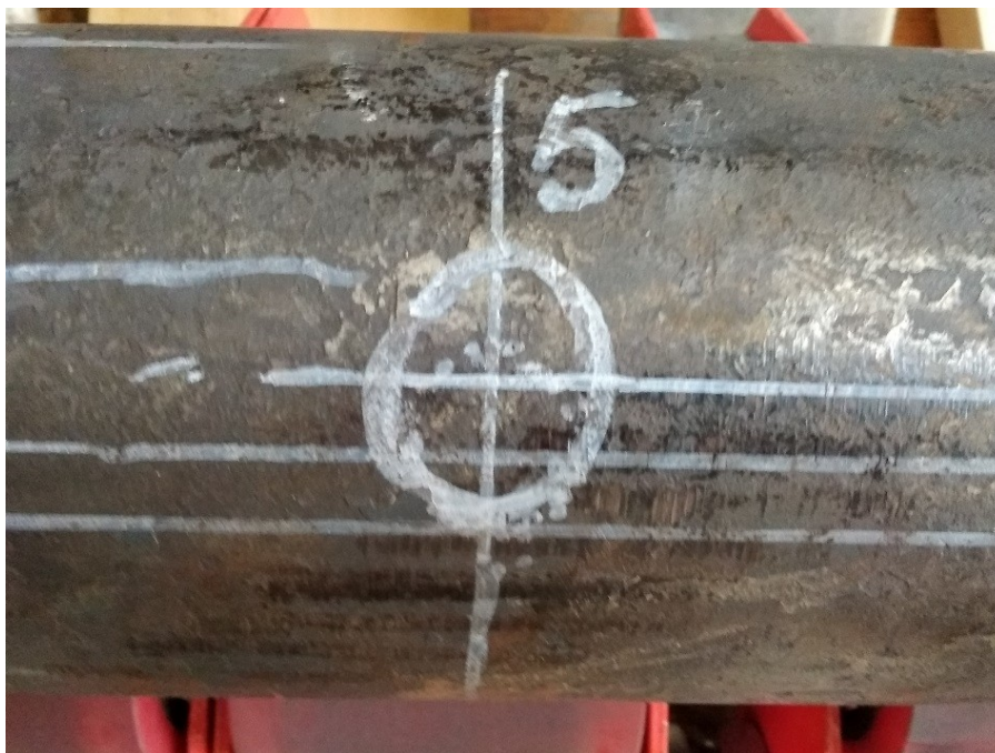
Рисунок 8 - Фотография дефекта № 5 тип: закат DOI: https://doi.org/10.60797/IRJ.2024.143.178.8
