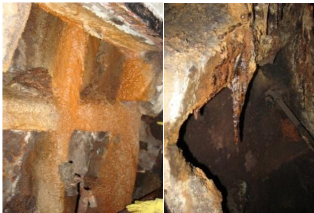
Фото 1 – Наросты и выносы с ржавым мокрым налетом (а); сталактит на ребре жесткости в тоннельных конструкциях (б)
