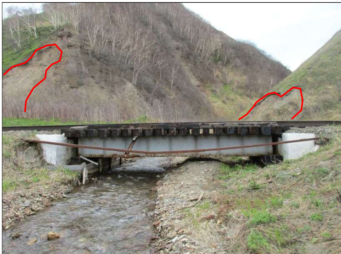
Рис. 3 – Общий вид склонов в районе моста (красным цветом показаны участки развития оползневых процессов)
