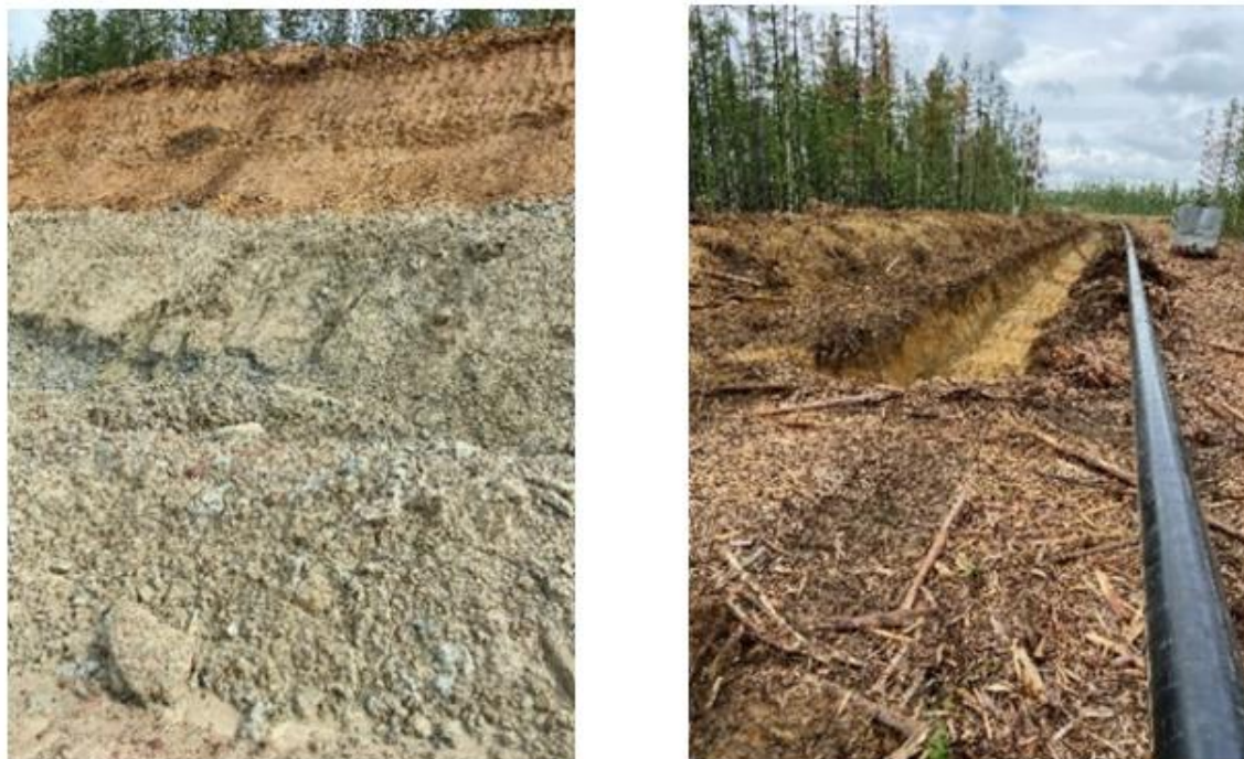
Рис. 1 – Фотографии грунта в зоне прокладки трубопровода
