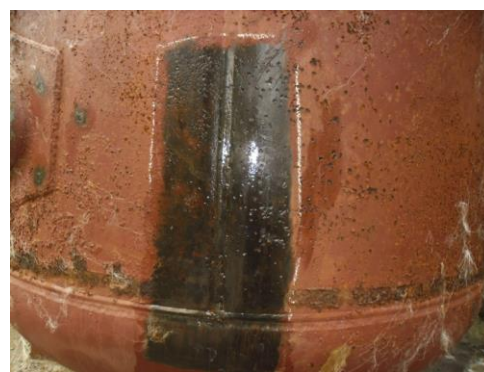
Рис. 2 – Фото обнаруженных дефектов на воздухоборнике
