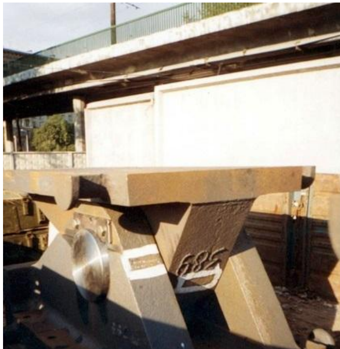
Рис. 3 – Шарнирная опора моста
