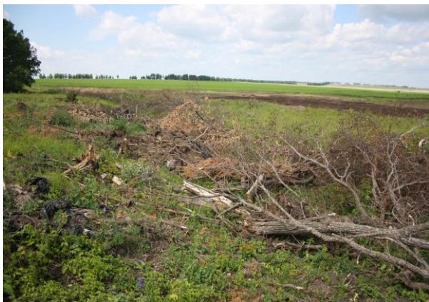
Рис. 2 – Создание основы для заполнения карстовых депрессий
