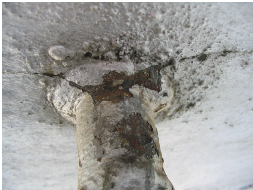
Рис.1 - Общий вид трещины в зоне варки дренажного штуцера Ду 25 в обечайку корпуса емкости.(вид снаружи)
