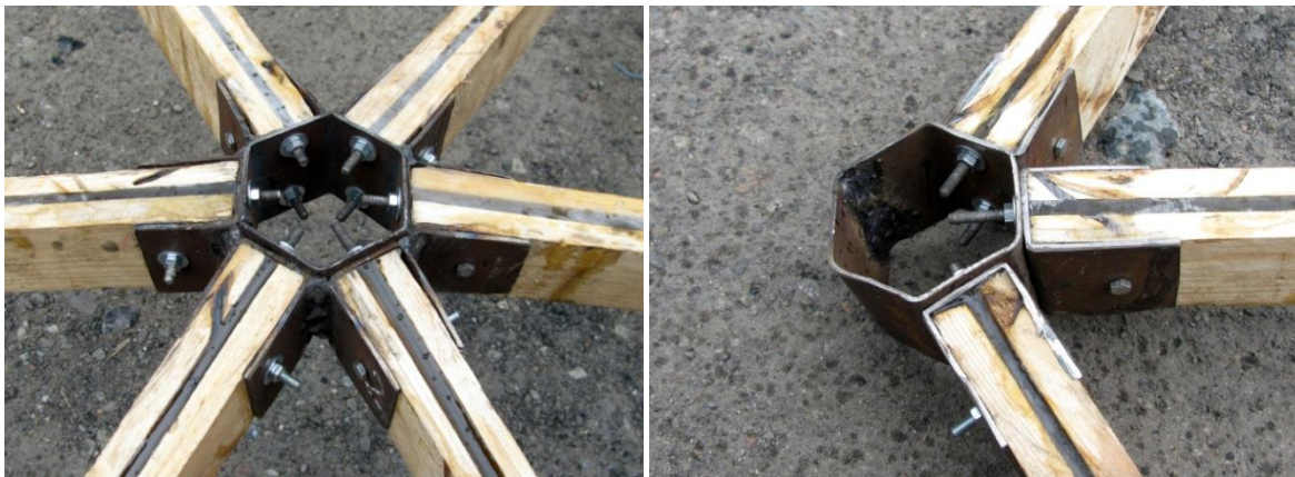
Рис. 2 – Узлы конструкции: центральный (слева), боковой (справа)
