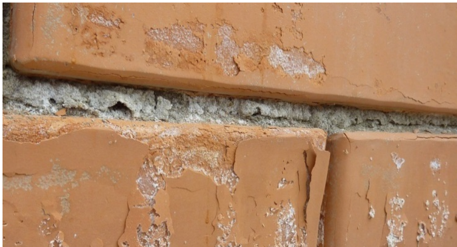
Рис. 2 – Процесс разрушения красного кирпича в результате влияния влаги и знакопеременных температур
