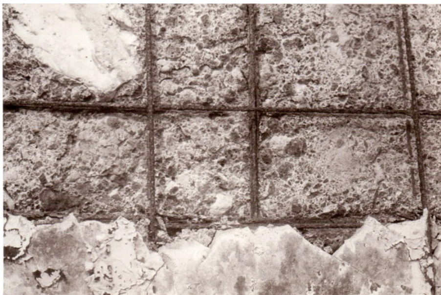
Рис. 1 – Разрушение поверхностного слоя керамзитобетонной панели
