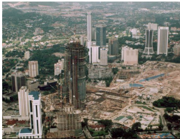
Рисунок 3 – Строительство башен Петронас в Куала-Лумпур из высокопрочного бетона
