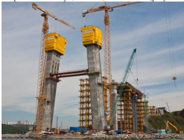
Рисунок 2 – Применение высокопрочного бетона при строительстве пилона вантового моста на остров Русский
